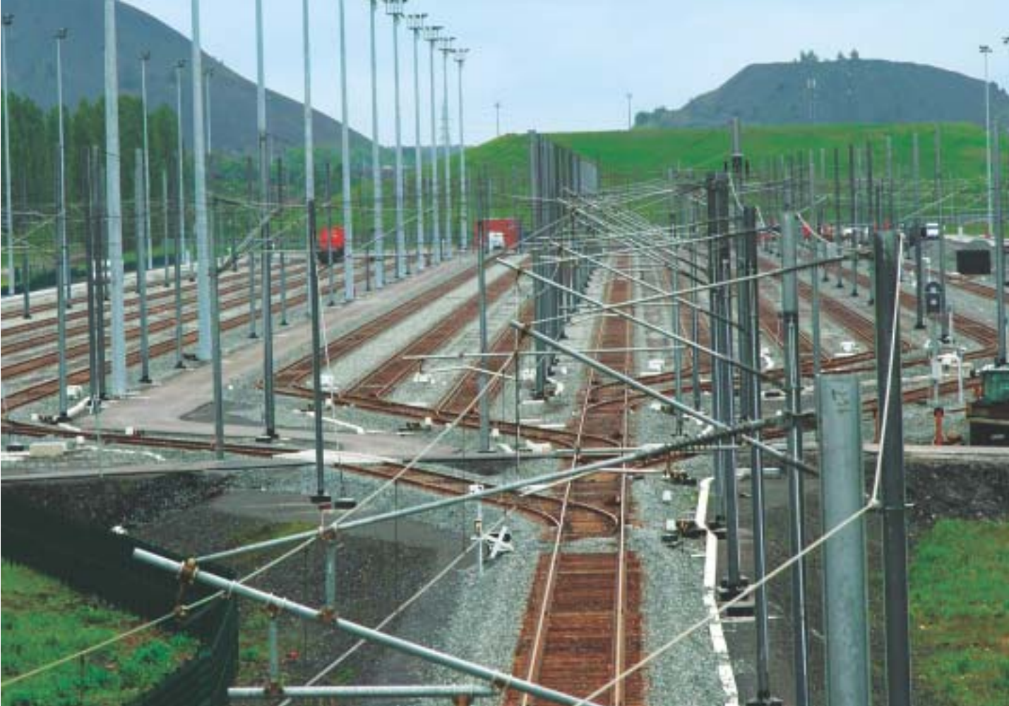
Le terminal trimodal de fret (rail-eau-route) Delta 3 à Dourges (Pas-de-Calais), est une réalisation de dimension européenne permettant de compenser une prochaine saturation de la zone logistique belge et hollandaise.
