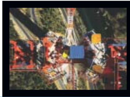
Vue du ciel, la pile P2 (245 mètres de hauteur, record du monde) s'apprête à recevoir le tablier lors du dernier lancement côté Nord.
