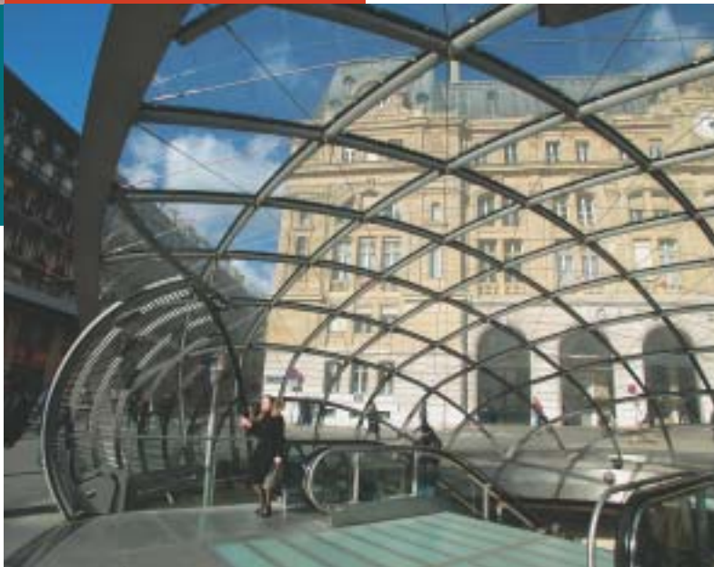
Les bâtiments publics, comme par exemple la sortie du métro parisien Météor à Saint-Lazare, font fréquemment appel à la mise en œuvre de matériaux et de techniques favorisant l'intégration paysagère.
