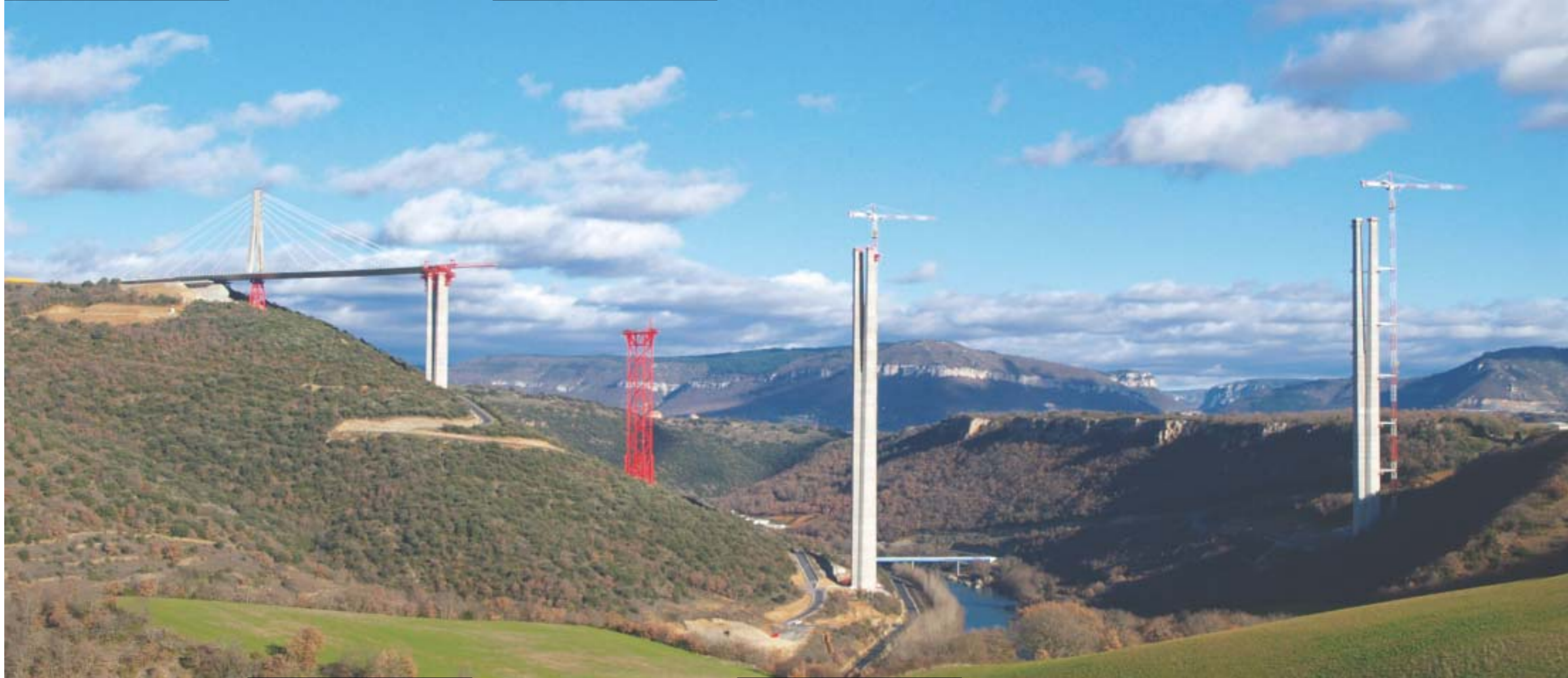
L'équipe s'active en tête de palée provisoire, gigantesque béquille temporaire, constituée de tubes d'acier d'un mètre de diamètre.
