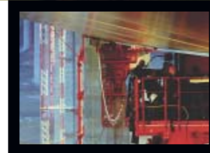
L'équipe s'active en tête de palée provisoire, gigantesque béquille temporaire, constituée de tubes d'acier d'un mètre de diamètre.
