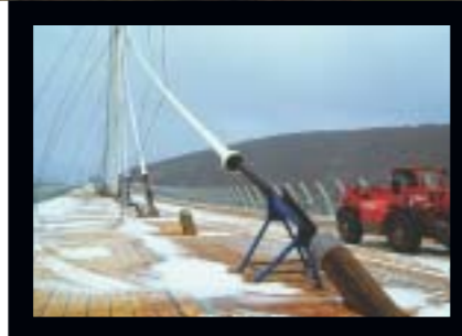
Au cours d'un lancement sous la neige, détail d'une nappe de haubans d'un pylône, dont les plus longs seront soumis à une tension de 900 tonnes.
