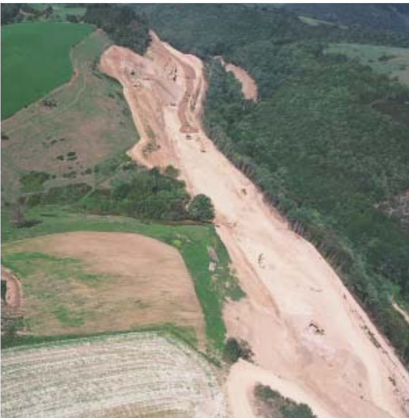
Travaux de terrassements sur la RN82 entre L'Hôpital-sur-Rhins et Neulise (Loire). Sur sept kilomètres se succèdent talus de déblais de 45 mètres et remblais de 25 mètres. Au total 2 100 000 m 3 de déblais et 1 700 000 m 3 de remblais.
